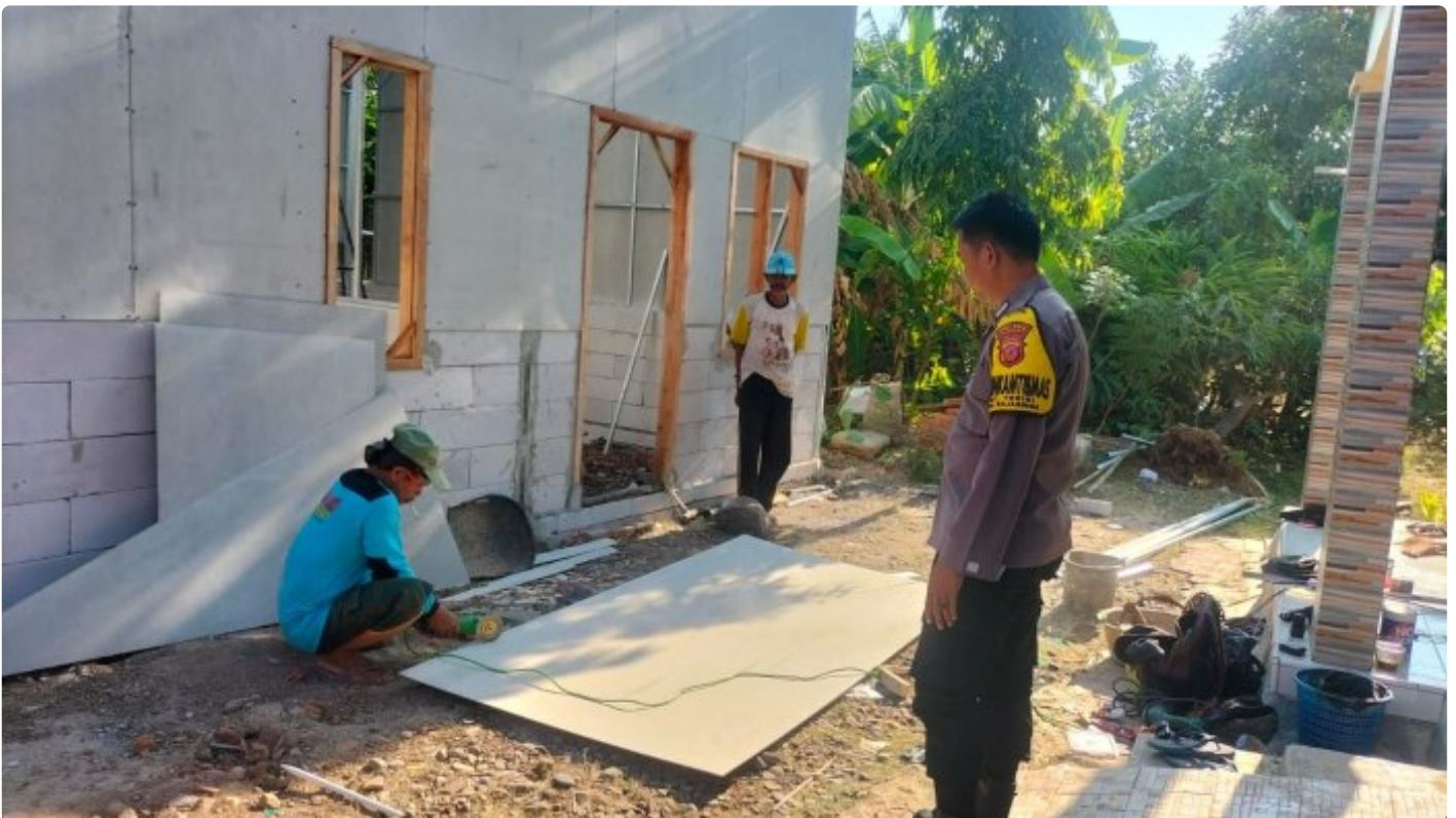
Bhabinkamtibmas Polsek Terisi Monitoring Pembangunan Rutilahu Dari Kapolres Indramayu.
